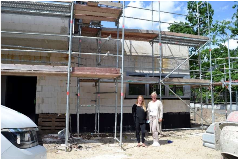
Nicole Krüger (Leitung Krippe) und Nele Westphal (Leiterin KJF-Bereich) vor der Baustelle im Fröbelweg
