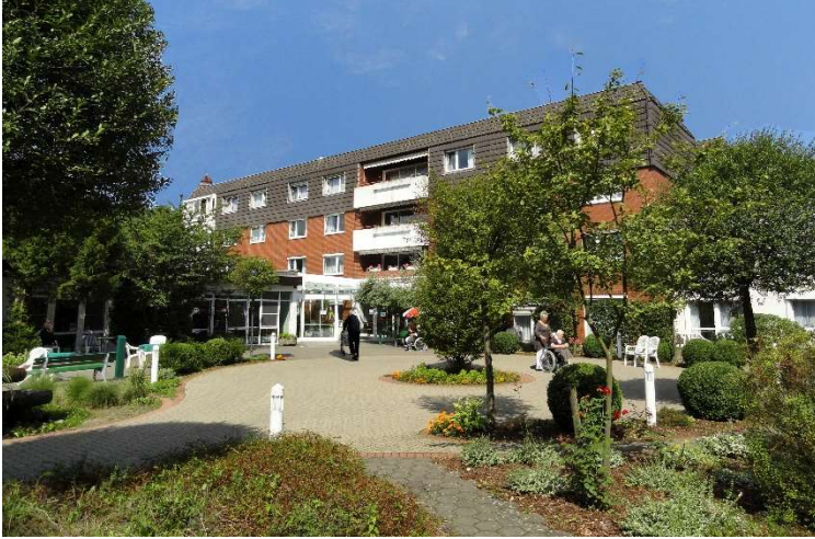
Rückansicht des „DRK Seniorenzentrum am Wasserturm“.
